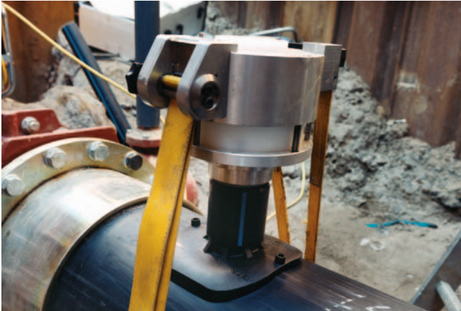
Die FRIATOP-Aufspannvorrichtung arbeitet pneumatisch und presst Sattelformteile vor dem Schweißen auf das PE-HD Rohr auf.
