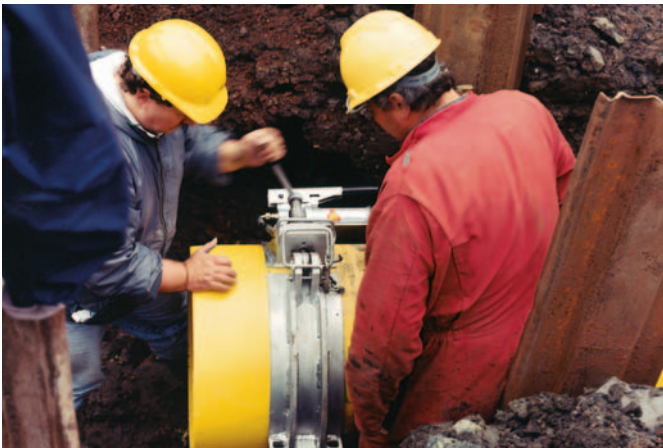
Die hydraulische Rundungsschelle rundet lagerungsbedingte Ovalität von \pm 3\% bei PE-HD-Rohren zurück. Einsatz von d 280 bis d 710.
