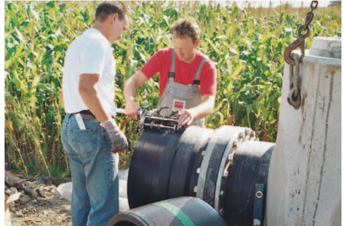
Das FRIATOOLS-Schälgerät FWSG 710 S für Stutzenfittings und Rohre d 250-710.
